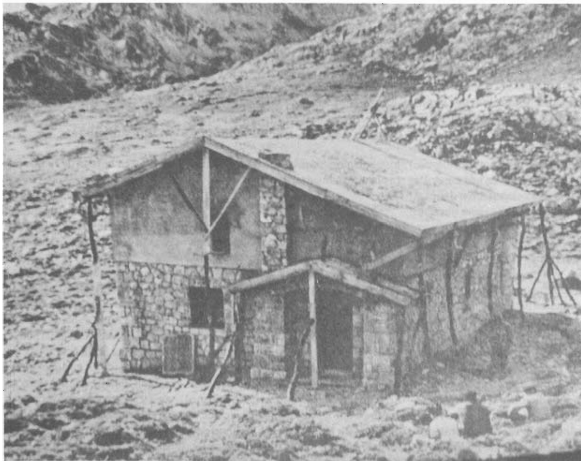
Refugio en construcción, año 1958
