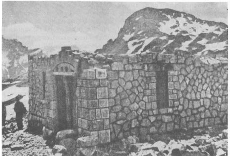
Refugio en construcción, año 1957
